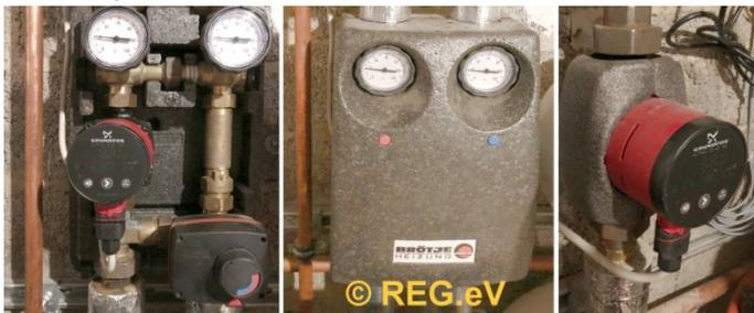
Bild (von links nach rechts): Beispiel Heizungspummentausch mit Hocheffizienzpumpe im Mischer (130 mm Einbaulänge) mit geöffneter und geschlossener Dämmung; Hocheffizienzpumpe (180 mm Einbaulänge) im Kreislauf der Fußbodenheizung
